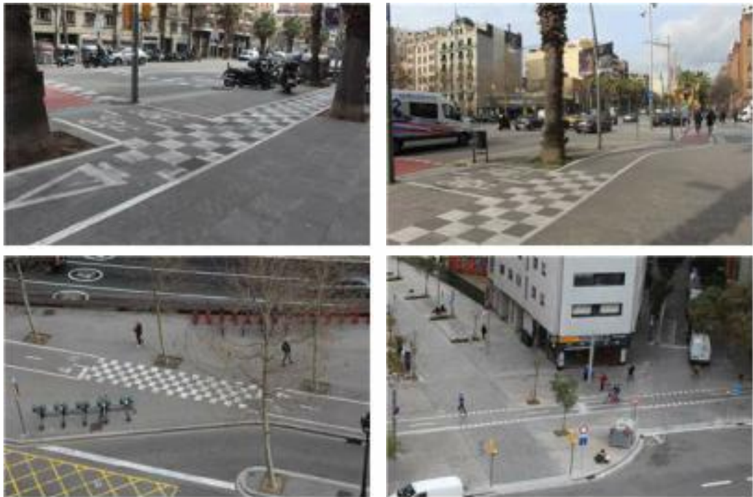
<그림 8-21> 차도 외 상충구간 자전거·개인형 이동장치 도로 노면처리 예시(스페인 바르셀로나)
